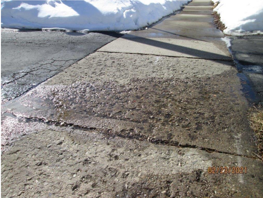
Spalling
