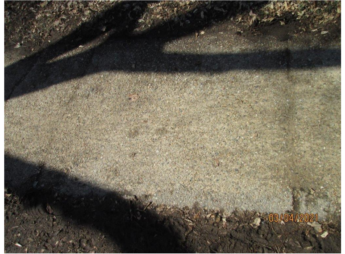
Spalling
